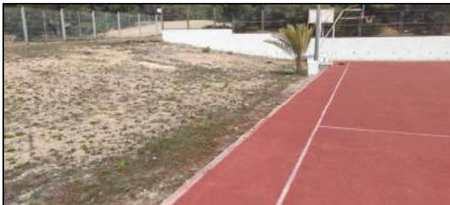
Fotografía 3: Tierras a excavar.
